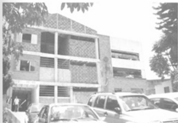
Avances en la construcción del nuevo bloque
