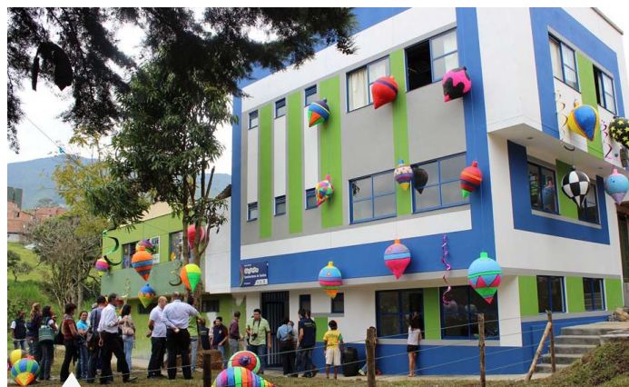
Sede actual “ Constructores de Sueños ”.
