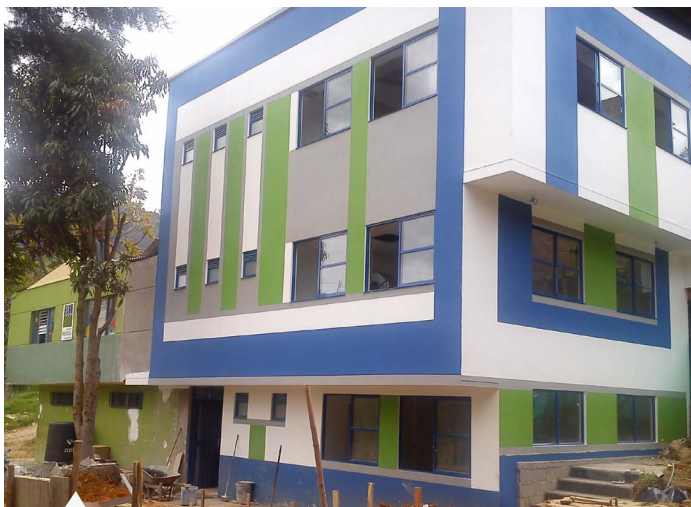
Imagen de la nueva fachada, que fue tomada mientras se ejecutaban los trabajos de la construcción.
